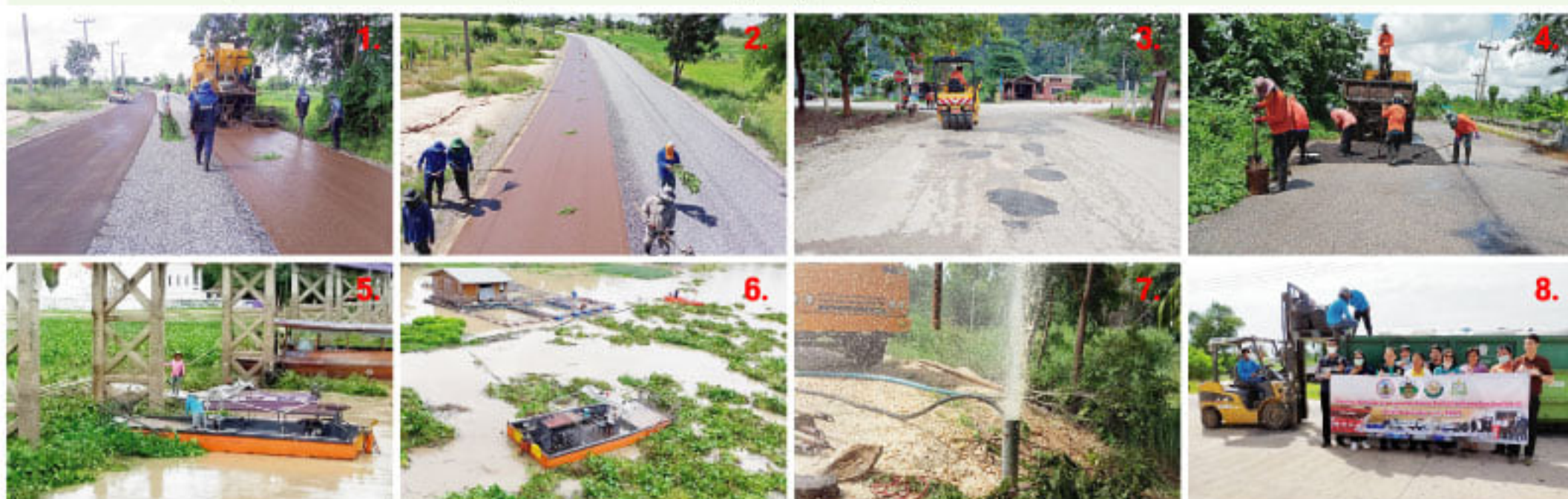
(1-2) อบจ.อุบลราชธานี ส่งเครื่องจักรกลชุดลาดยางพร้อมเจ้าหน้าที่ปฏิบัติงานซ่อมสร้างถนนลาดยาง Cape Seal สายแยกทางหลวงหมายเลข 333 - บ้านหนองพังคำ อ.หนองขาหย่าง จ.อุบลราชธานี (3-4) อบจ.อุบลราชธานี นำเครื่องจักรกลพร้อมเจ้าหน้าที่เข้าปรับปรุงซ่อมแซมถนนสายแยกทางหลวงหมายเลข 3211 - บ้านจัน อ.บ้านไร่ และถนนสายบ้านหนองรัก - บ้านบึงฝาง อ.ลานสัก จ.อุบลราชธานี (5-6) อบจ.อุบลราชธานี ดำเนินการกำจัดผักตบชวาและวัชพืชในแม่น้ำสะแกกรังในเขตเทศบาลเมืองอุบลราชธานี บริเวณสะพานวัดอุโปสถาราม ระหว่างวันที่ 19 - 21 ตุลาคม 2563 โดยใช้เครื่องจักรกลพร้อมเจ้าหน้าที่เข้าดำเนินการ (7) อบจ.อุบลราชธานี ดำเนินการเป่าล้างบ่อน้ำบาดาลและซ่อมบารุงบ่อ บริเวณ ม.6 บ้านหนองชุมแสง ต.ทัพทัน อ.ทัพทัน และ ม.8 บ้านหนองงาแซง ต.ทุ่งโพ อ.หนองดง จ.อุบลราชธานี เพื่อบรรเทาความเดือดร้อน (8) อบจ.อุบลราชธานี ดำเนินการจ้างบริษัทเอกชนมารับขยะอันตรายไปกำจัดตามหลักวิชาการเป็นที่เรียบร้อยแล้วเมื่อวันที่ 15 ตุลาคม 2563 ณ ศูนย์รวบรวมขยะอันตรายชุมชนจังหวัดอุบลราชธานีขององค์การบริหารส่วนจังหวัดอุบลราชธานี โดยจำนวนขยะอันตรายที่ส่งไปกำจัด จำนวนทั้งสิ้น 10,920 กิโลกรัม
